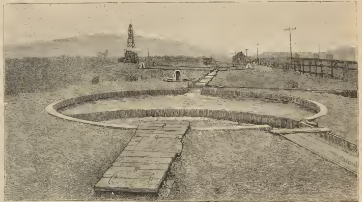
Fig. 2. - Pozo artesiano de los alrededores de Riverside (California). Estanque de aireación del agua
